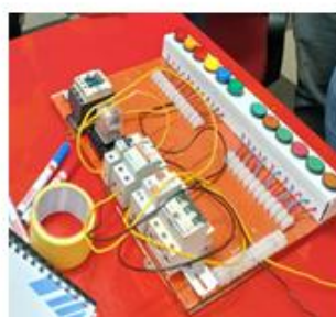
Motor wiring up
